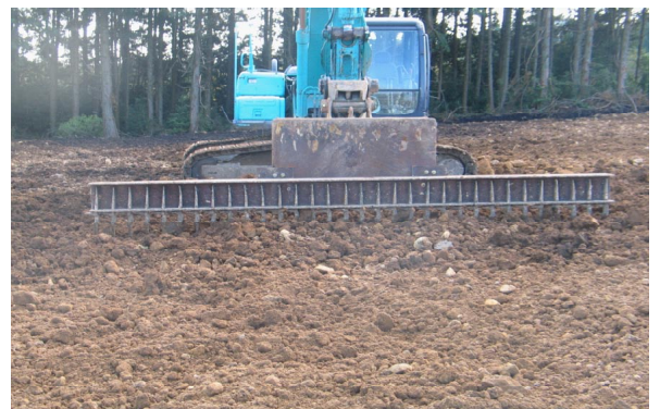
写真No.1 石礫除去機を当社で作製(H鋼を溶接)
